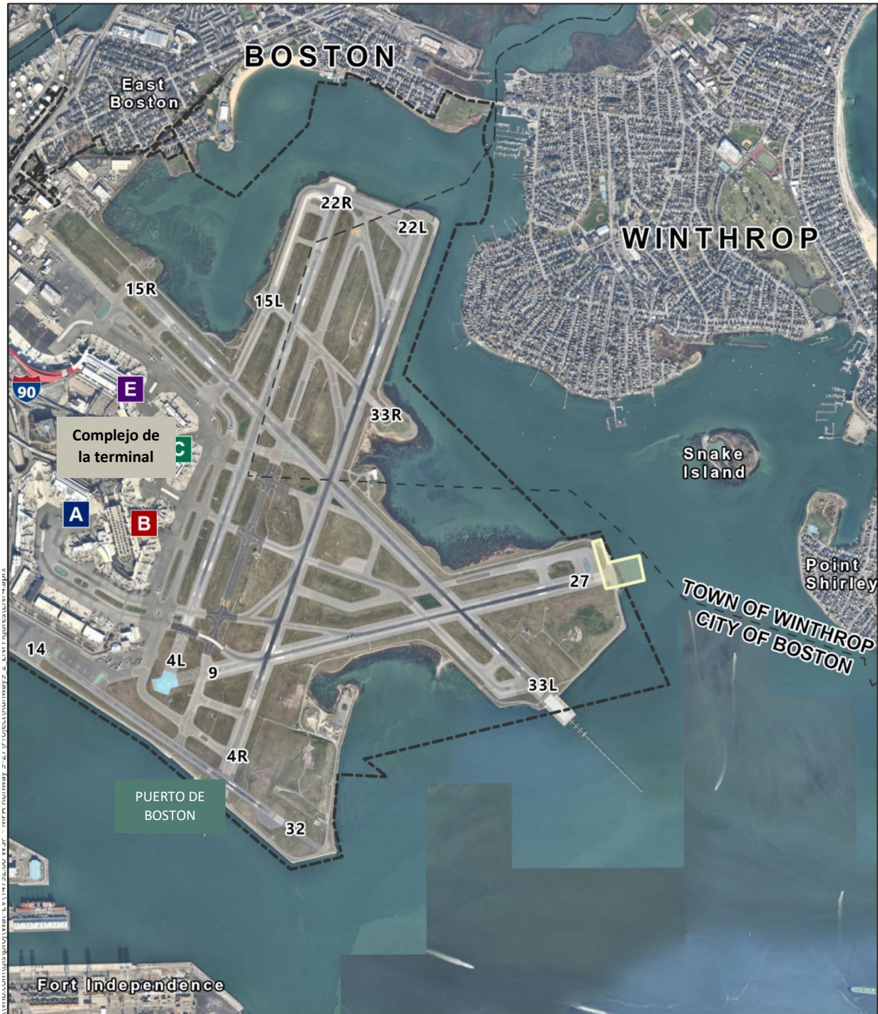
Figura RE-1 Vista aérea del aeropuerto Logan
